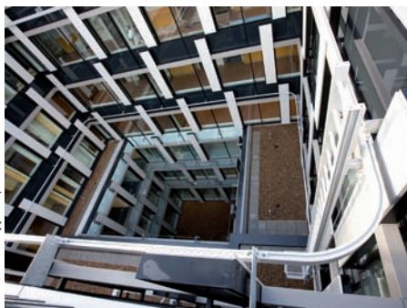
Tiefe Einblicke: 17 Innenhöfe spenden Licht im Neuen Klinikum.
